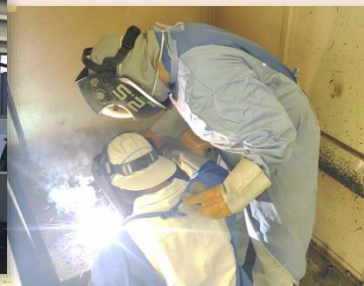
電気溶接職種
