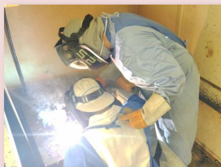
電気溶接職種
